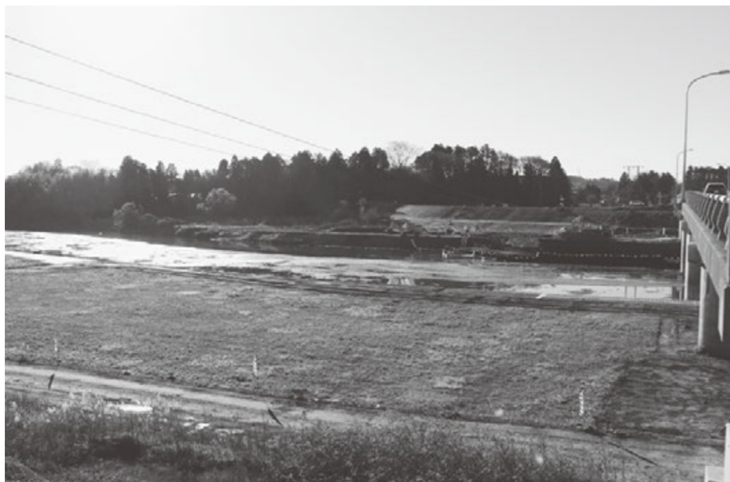
▲河道掘削が進む吉田川(粕川大橋側から)
