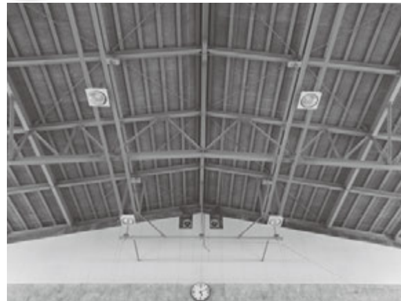
▲安心して快適な利用に 海洋センターアリーナの室内LED化、 屋根の修繕工事
