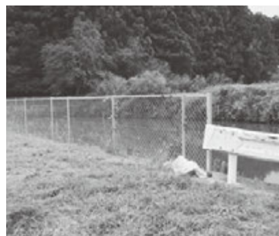
▲事故防止対策完了(土橋)
