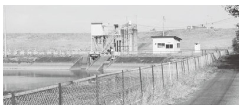
▲後谷地排水機場
