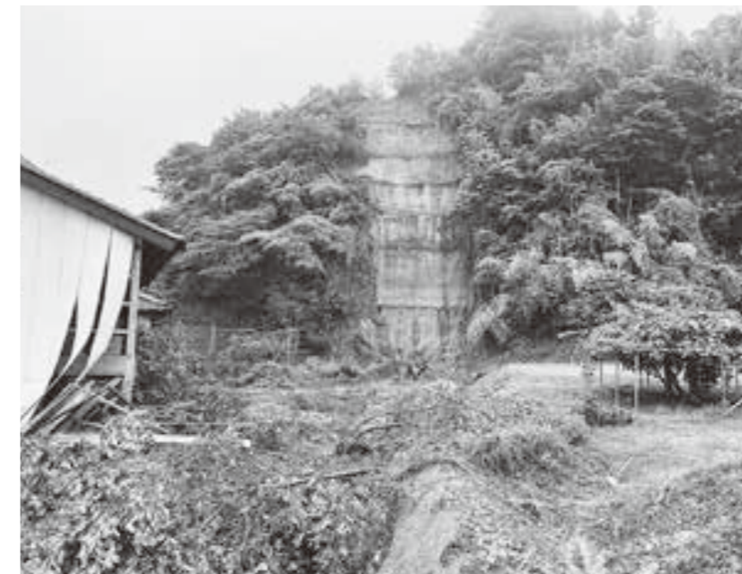
▲調査の始まる被災箇所（木ノ崎）
