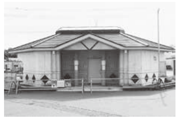
▲1日でも早い工事完成を
