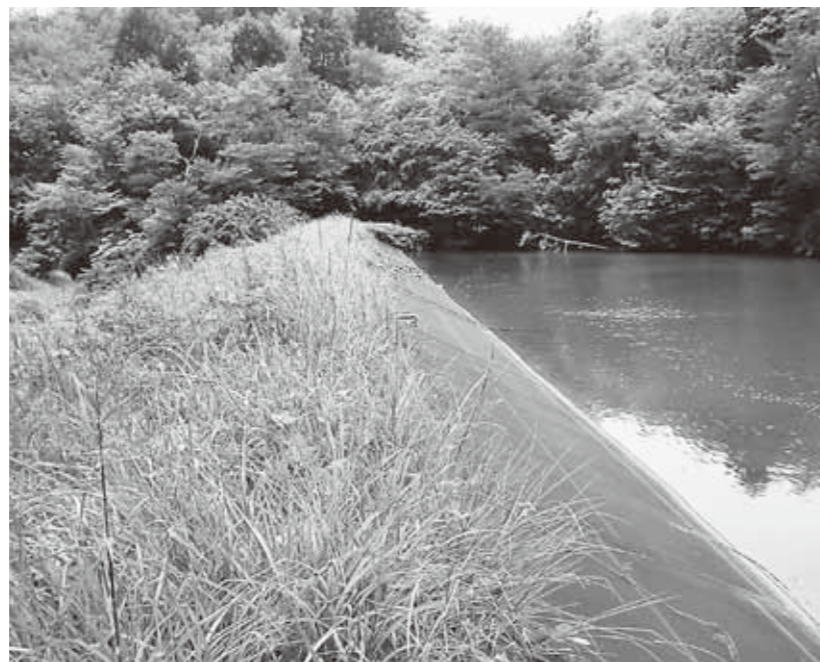
▲対策が必要なため池
