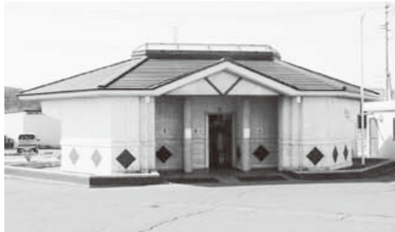
▲道の駅外トイレ
