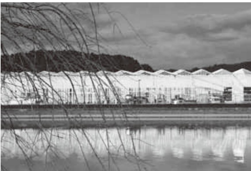
▲台風19号被害による復興再建が急ピッチで進む大型ハウス
