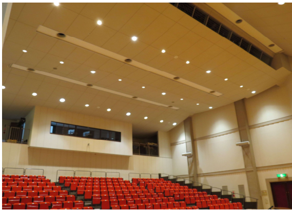
設備改修工事（ホール照明）
