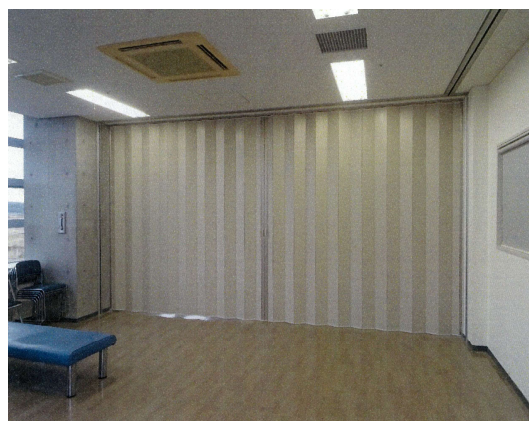
会議室パーテーション修繕工事
