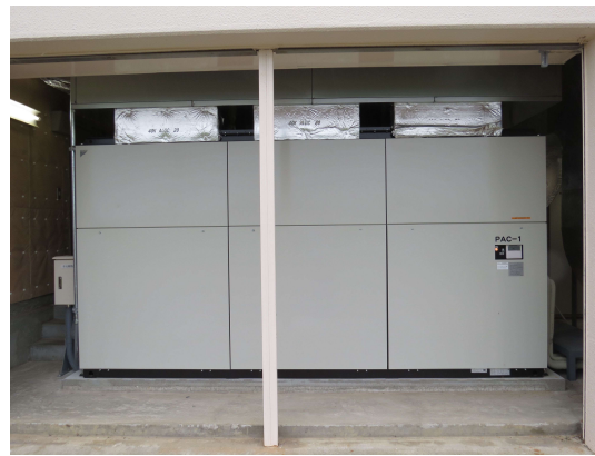
設備改修工事（空調設備）
