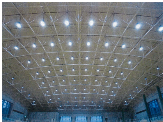
電気設備改修工事（アリーナ照明）
