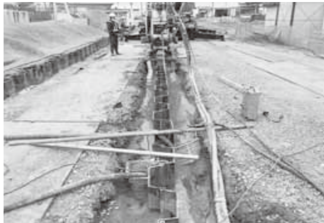
▲災害復旧工事 (B&G 野球場)
