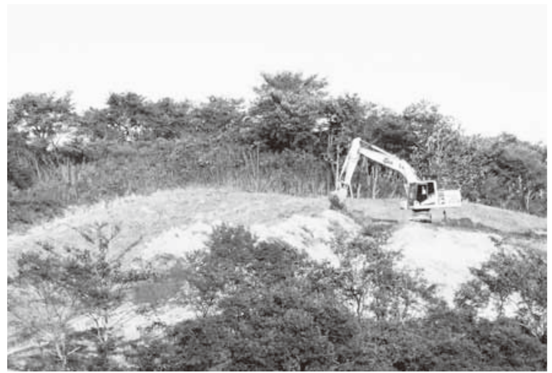
▲発電所用地の造成工事(味明地区)
