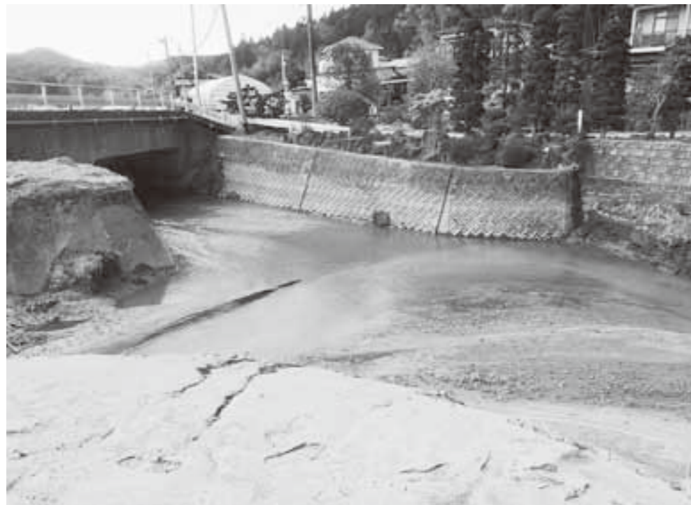
▲西光寺川(東成田)浚渫工事着手
