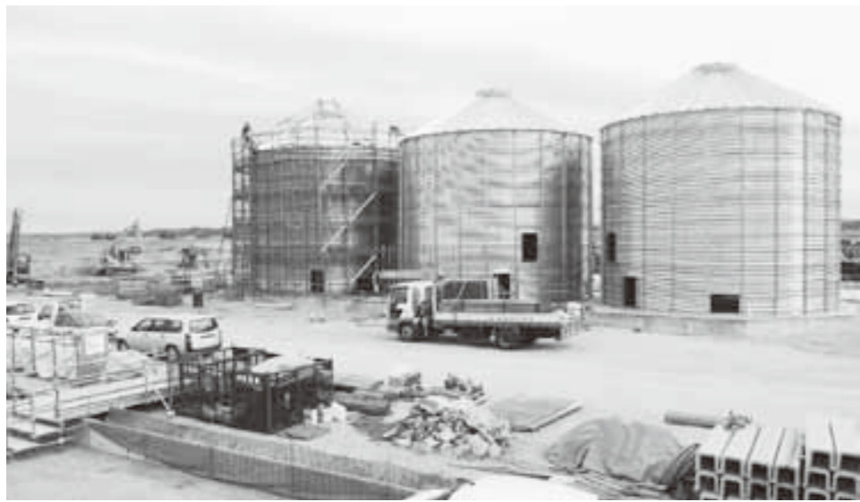
▲建設が進むカントリーエレベーター
