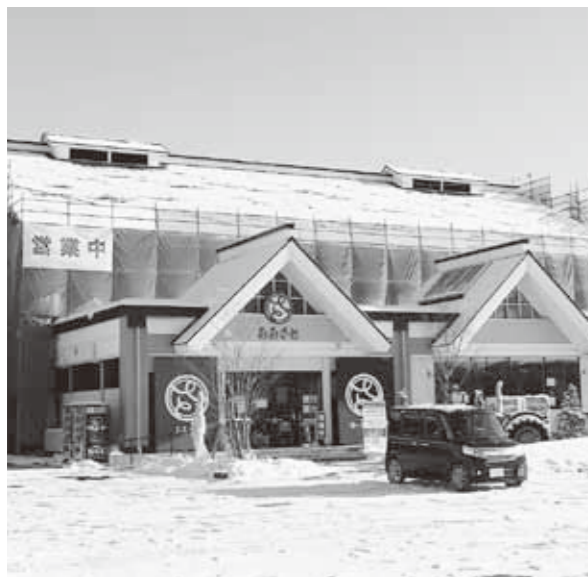
▲物産館 屋根外壁塗装等修繕工事
