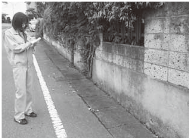
▲危険ブロック塀の点検
