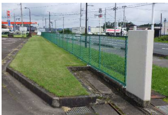
フェンス設置工事
