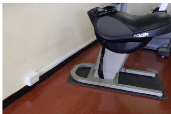
健康器具用コンセント設置工事
