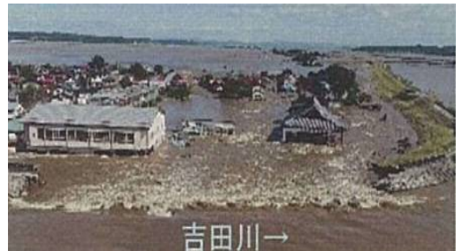
宮城県大郷町 吉田川堤防決壊状況
