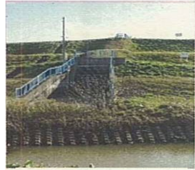
内浦緊急排水樋門（呑口部）
