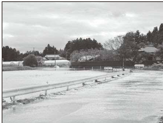
▲冠水した町道
