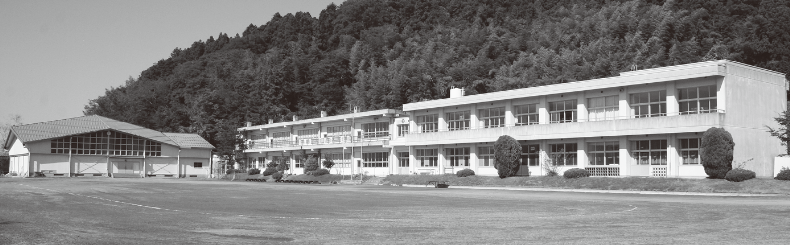
▲使い勝手を良くするため、一部解体が予定される（大松沢社会教育センター）
