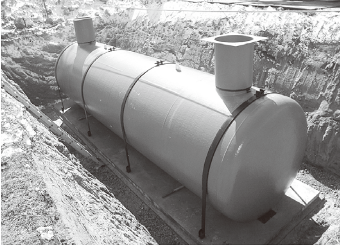
▲埋設される防火水槽
