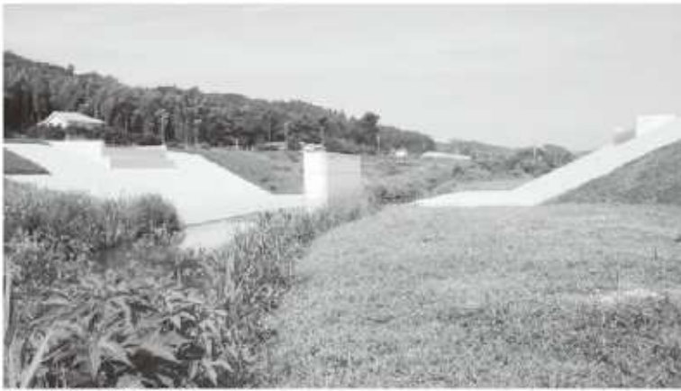
▲早期完成が望まれる上戸橋
