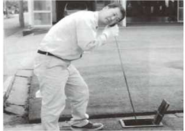
▲専門調査員による漏水調査
