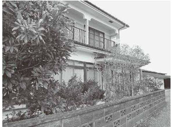
▲町内にある空き家。
