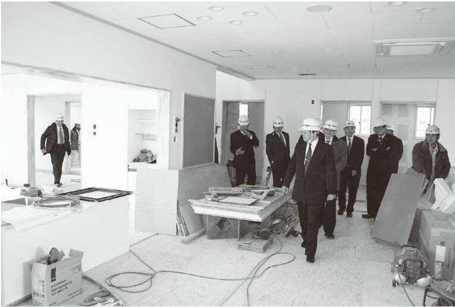
▲本町独自の児童館建設を（松島町児童館建設工事現場を視察）
