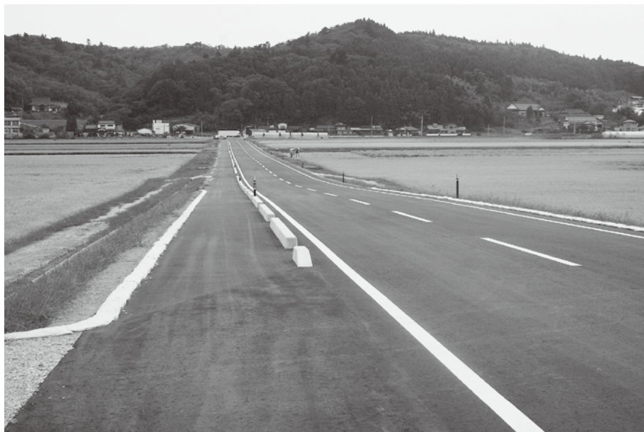
▲開通がまたれる上戸線（大松沢地区）
