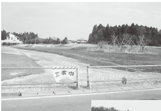
▲造成中の高崎団地
