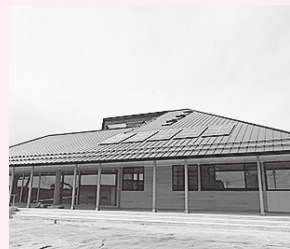
粕川地区防災コミュニティセンター
