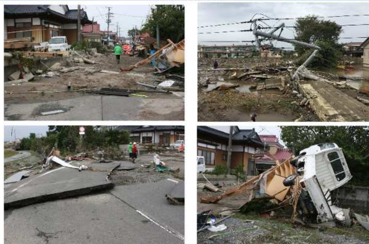
被災直後の状況
