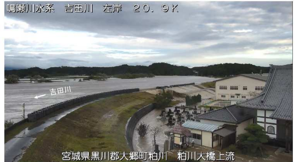
台風第19号 吉田川左岸(20.9k)の越流状況
