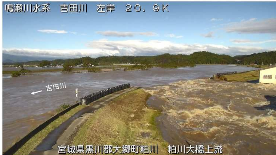
台風第19号 吉田川左岸(20.9k)の決壊状況
