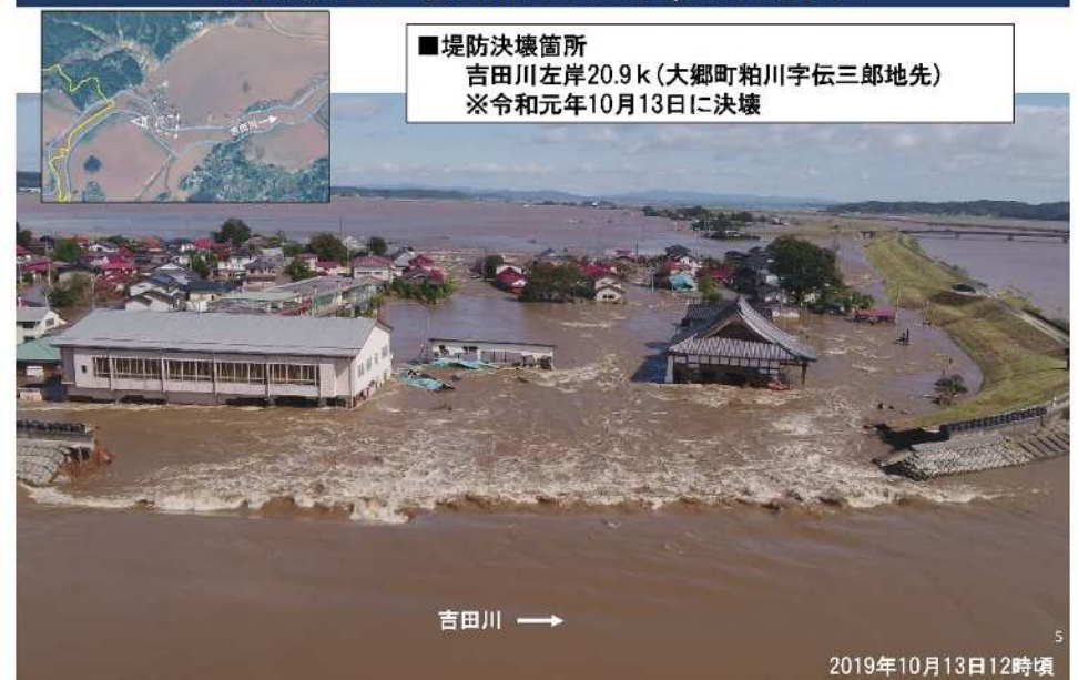
台風第19号 吉田川左岸(20.9k)の決壊状況
