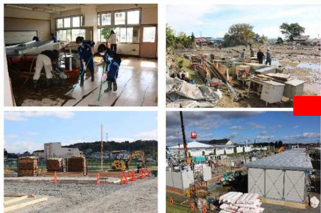
片付け状況と仮設住宅建築
