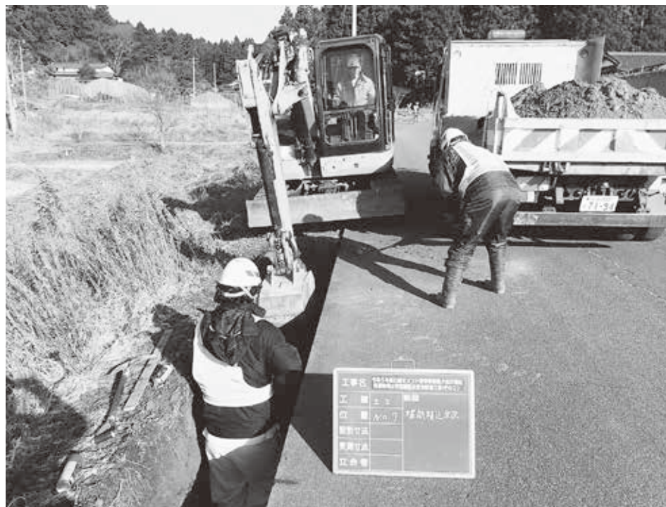
▲（大松沢下町）水道管更新事業
