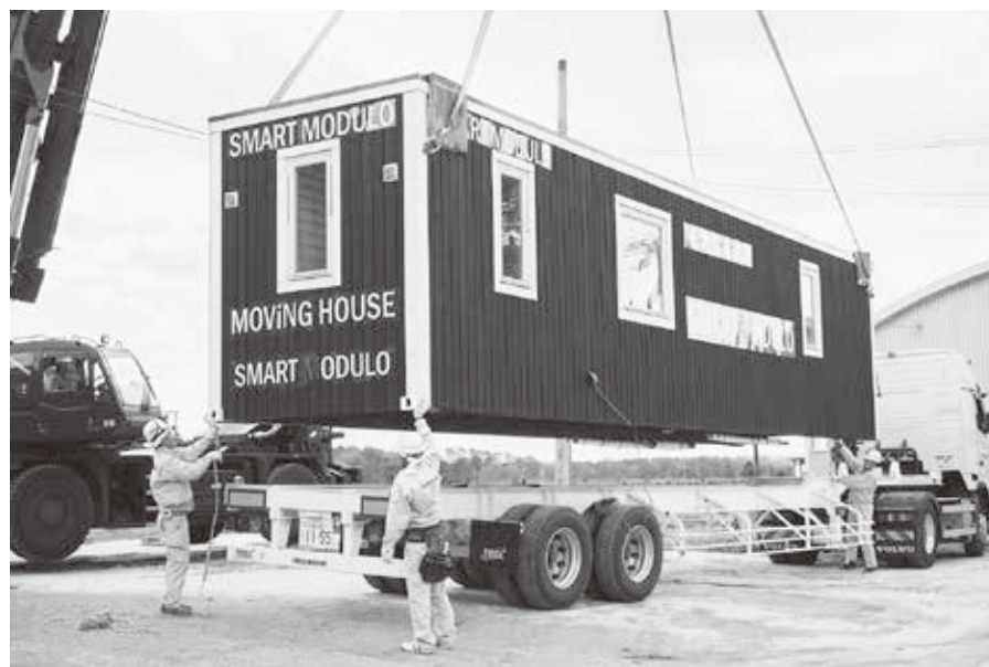
▲工場で完成し現場に移動、迅速に設置。
