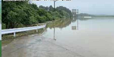
道路冠水 (粕川大橋周辺)
