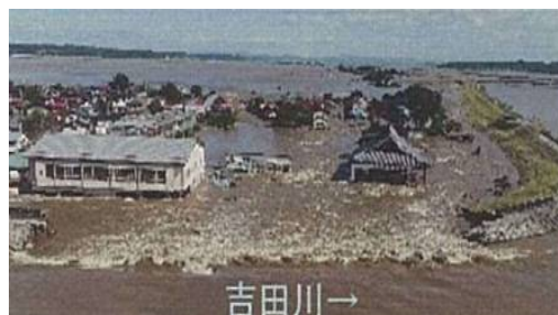
宮城県大郷町 吉田川堤防決壊状況
