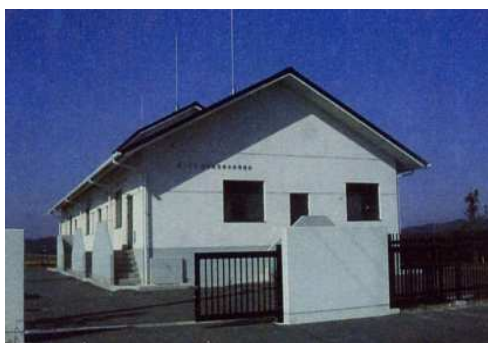
粕川地区農業集落排水処理施設
