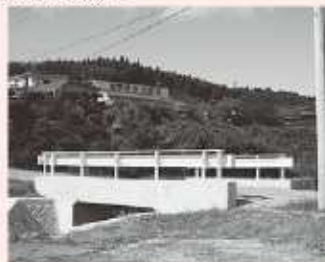
改良された山下橋
